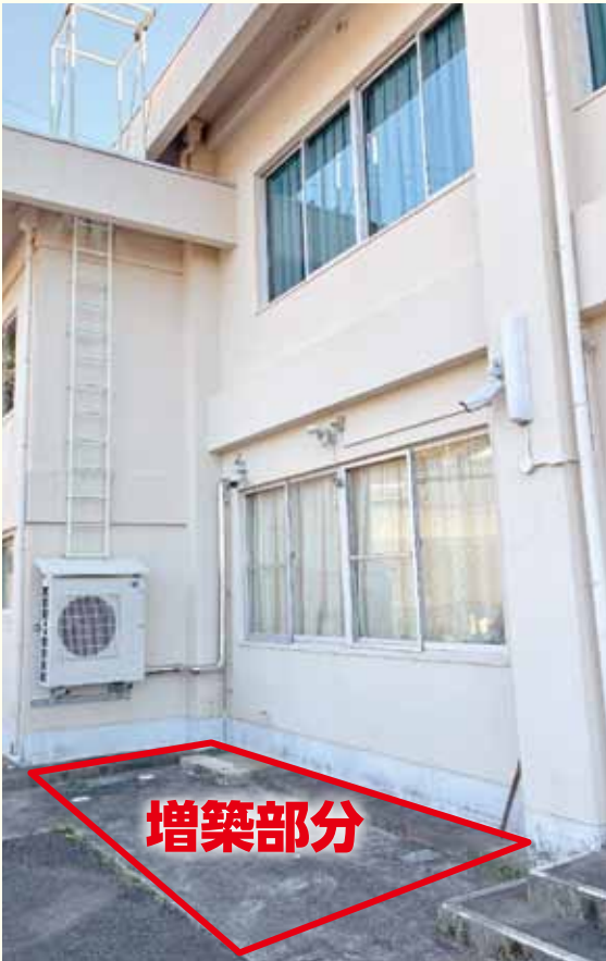
既存の共用トイレが男性用に改修、その横に女性用トイレが増設される
