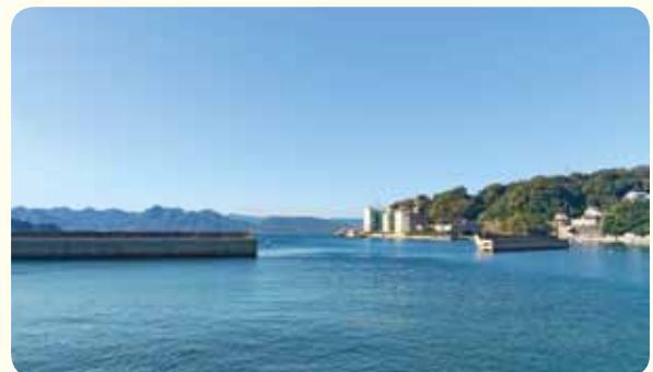
④高波・高潮の備え（坂町の離岸堤）
