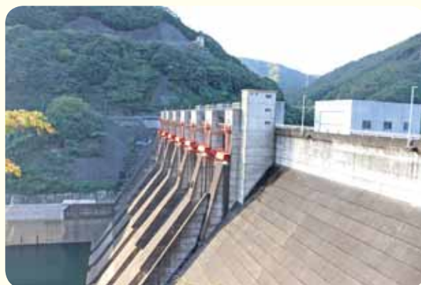
非常用洪水吐
