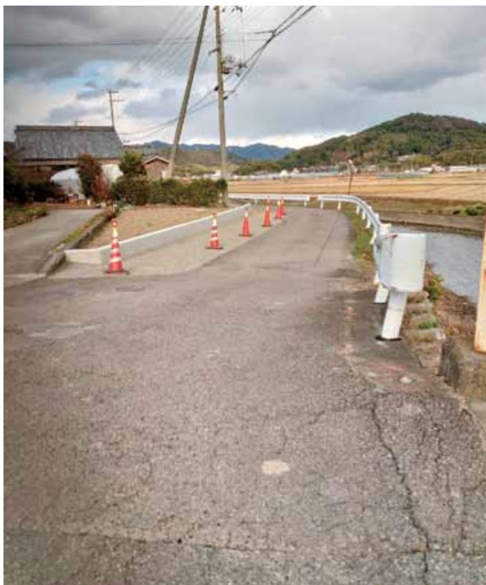
拡幅中の入山周囲2号線
