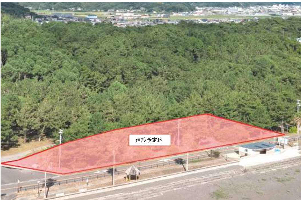
▲水産加工販売施設建設予定地
