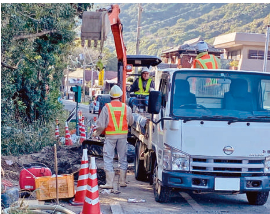
▲令和5年度水道管布設工事現場（和田地区）
