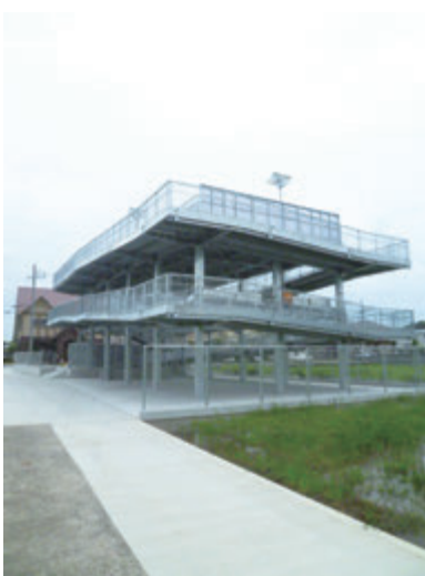
▲ 上田井地区津波避難タワー
