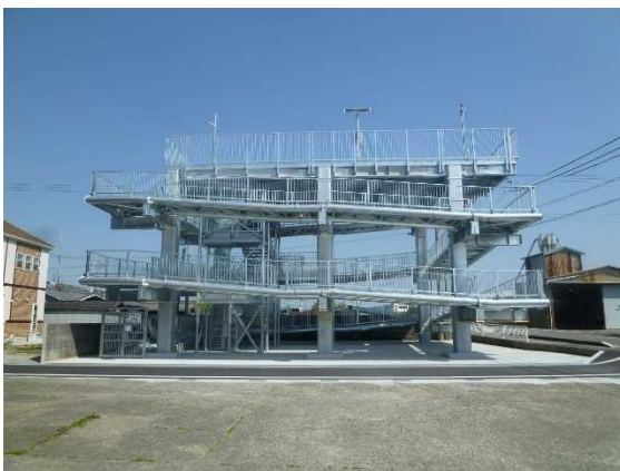
令和 2 年 3 月 竣工 浜ノ瀬地区津波避難タワー
