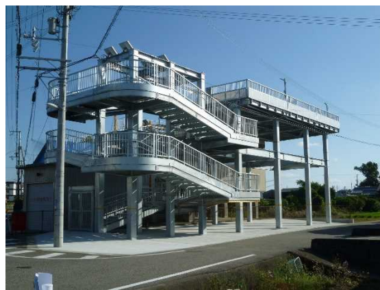
令和 2 年 10 月 竣工 田井畑地区津波避難タワー
