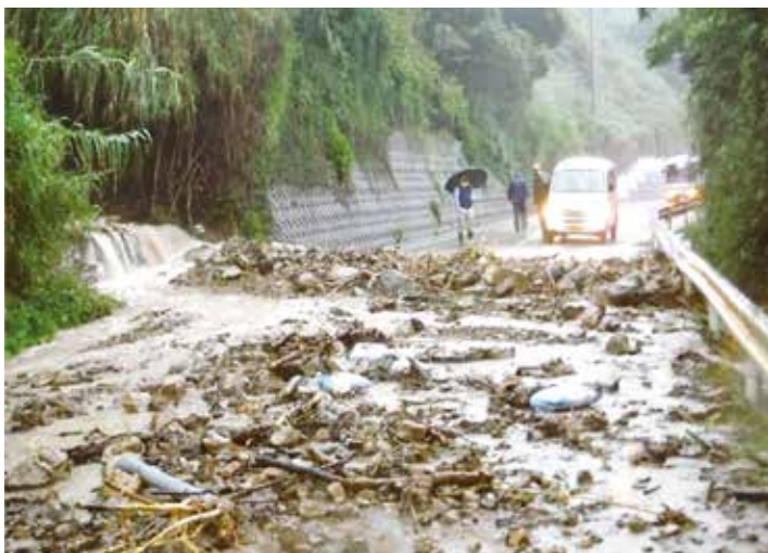
▲平成29年 台風21号降雨による土石流
