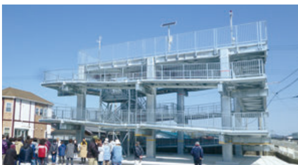
▲ 浜ノ瀬避難タワー完成写真
