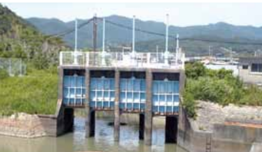
▲上流側の東裏川樋門
