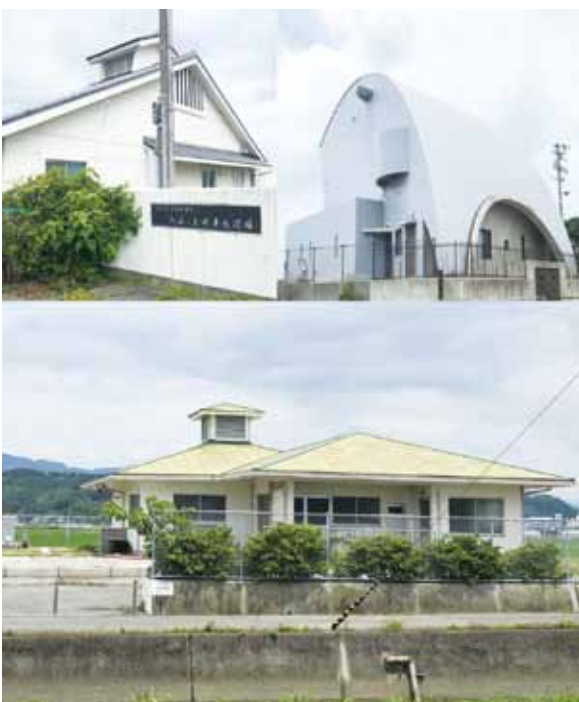
▲稼働中の和田・松原地区処理場
