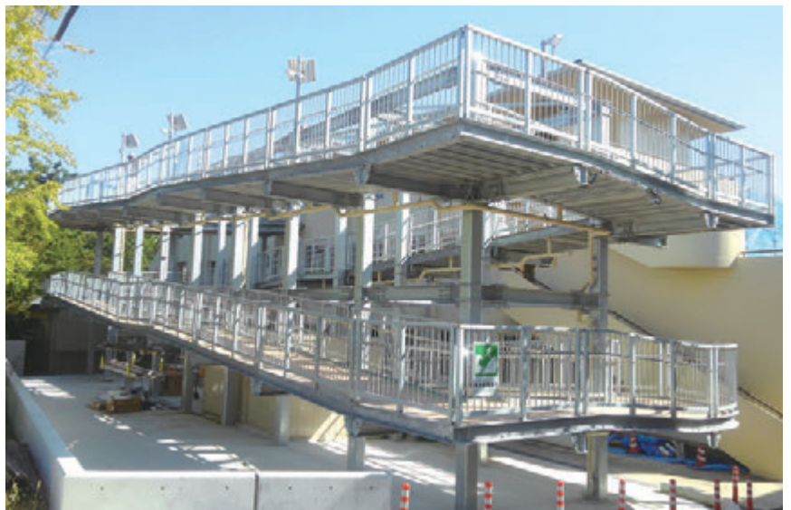
▲老人ホームの避難用スロープ
