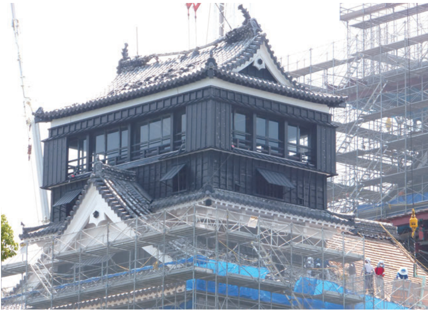
▲修復中の熊本城
