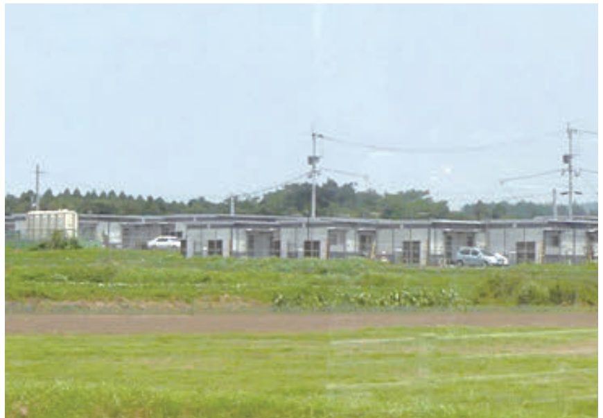
▲益城町の仮設住宅
