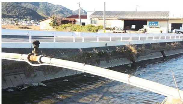
▲かさ上げされた和田川護岸
