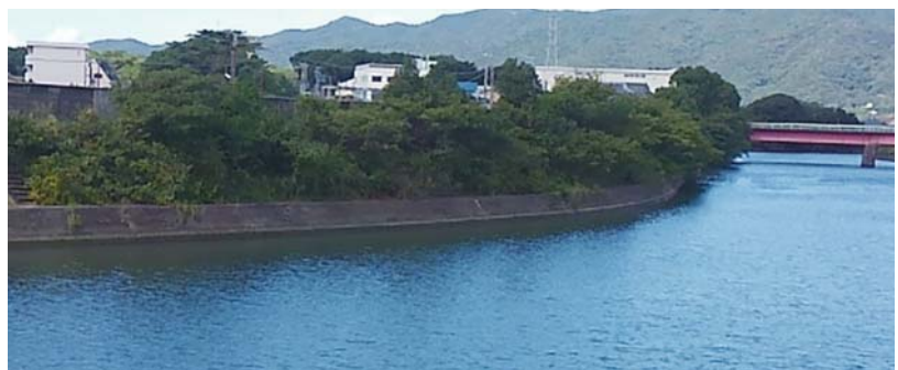
▲大川橋上流護岸
