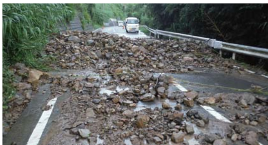
▲大雨による土砂崩れ (9/20)
